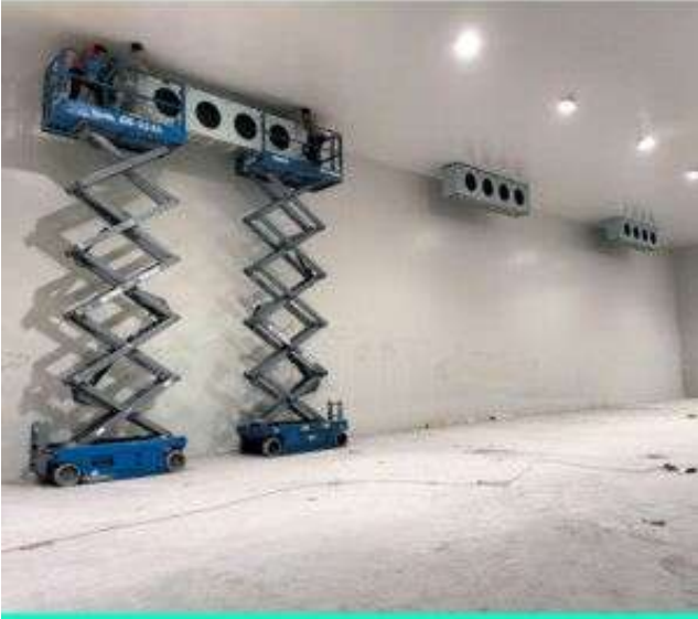
Cámaras de Refrigeración
